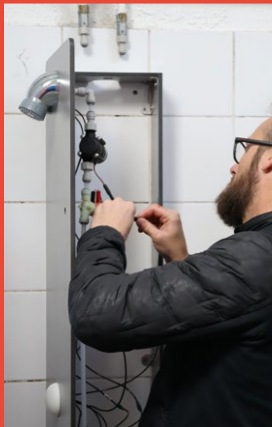
La modification de l'ensemble des douches a représenté une dépense de 25 000 € pour la commune.
